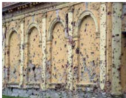
Foto: Snježana Požar
